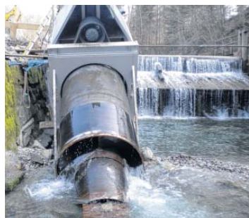
Albrechts Versuchsanlage in St. Anton
